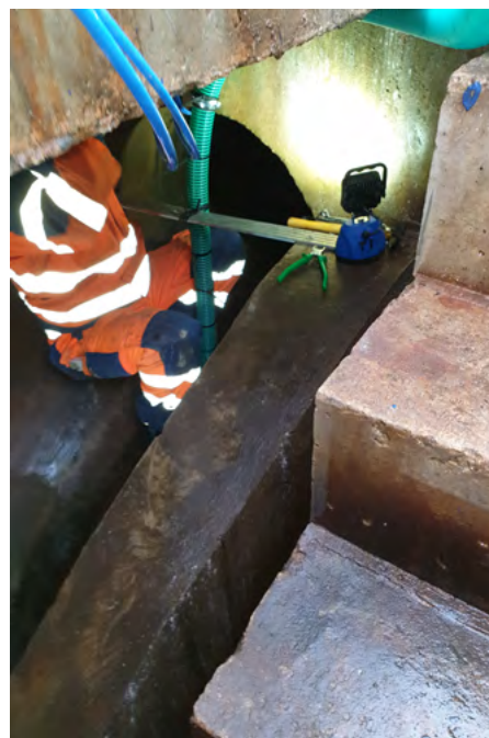
Geeignete Probennahmestellen, wie hier der Zulauf eines unterirdischen Regenbeckens, sind nicht immer leicht zugänglich.
